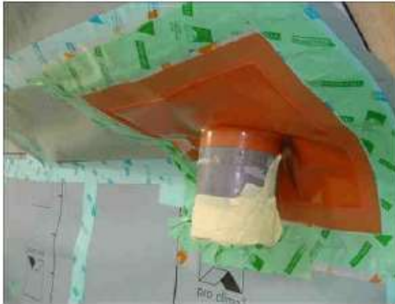
Figures 33 et 34 : illustrations de la difficulté de l'étanchéité dans les « détails » de la finition (source : Wouter Hilderson et C. Ferdinand, présentation midi du développement durable)
