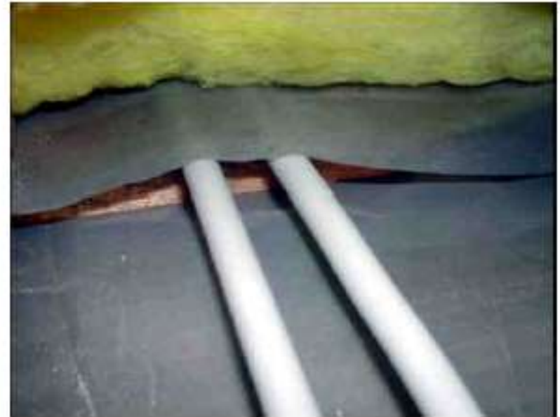
Figures 33 et 34 : illustrations de la difficulté de l'étanchéité dans les « détails » de la finition (source : Wouter Hilderson et C. Ferdinand, présentation midi du développement durable)
